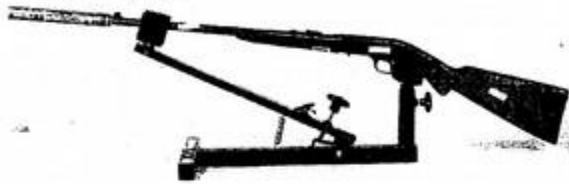
Bild 5 visar gevärspipan G4, kolven G5 och ljuddämparen G6 hopmonterade. Vapnet är fotograferat i Tekniska rotelns vapenstall.
